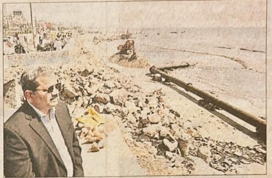
డ్రెడ్జింగ్ పనులను పరిశీలిస్తున్న పోర్ట్ చైర్మన్ రామ్మోహన్ రావు
